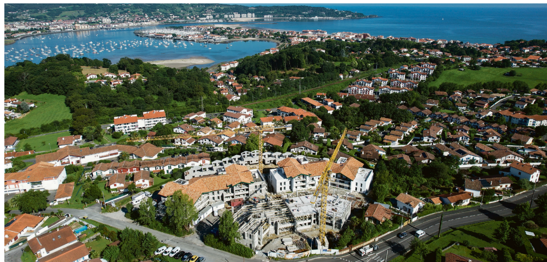
Chantier des Résidences Orioko Etxeak et Itsas Talaia à Hendaye. © X. Dumoulin
