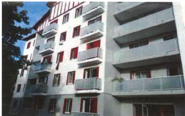
Les nouvelles fenêtres améliorent le confort thermique
