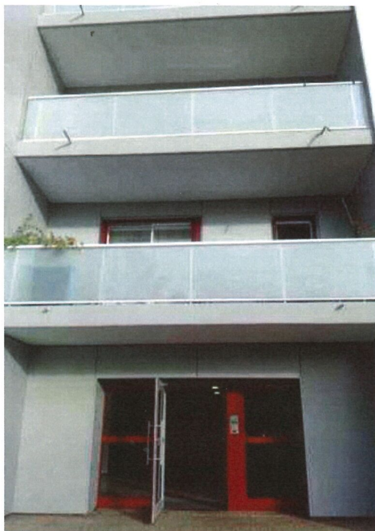
Les garde-corps et les menuiseries ont été remplacés. PHOTOS E. F.
