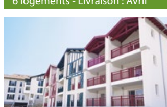
Saint-Pierre-d'Irube - « Urkia » 92 logements - Livraison : Juin
