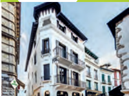
ST JEAN DE LUZ - Résidence « Garrouteigt » 2 logements Livraison : Octobre
