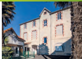
ARTHEZ DE BÉARN - Résidence « Le Saubestre » 6 logements Livraison : Octobre
