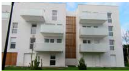
Anglet - Résidence « l'avant Cap » 20 logements - Livraison : février
