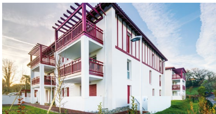
MOUGUERRE - « Résidence Le Jardin d'Emma » 14 logements - Livraison : Décembre
