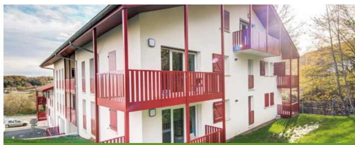
USTARITZ - « Résidence Mahasti Landa » 18 logements - Livraison : Novembre
