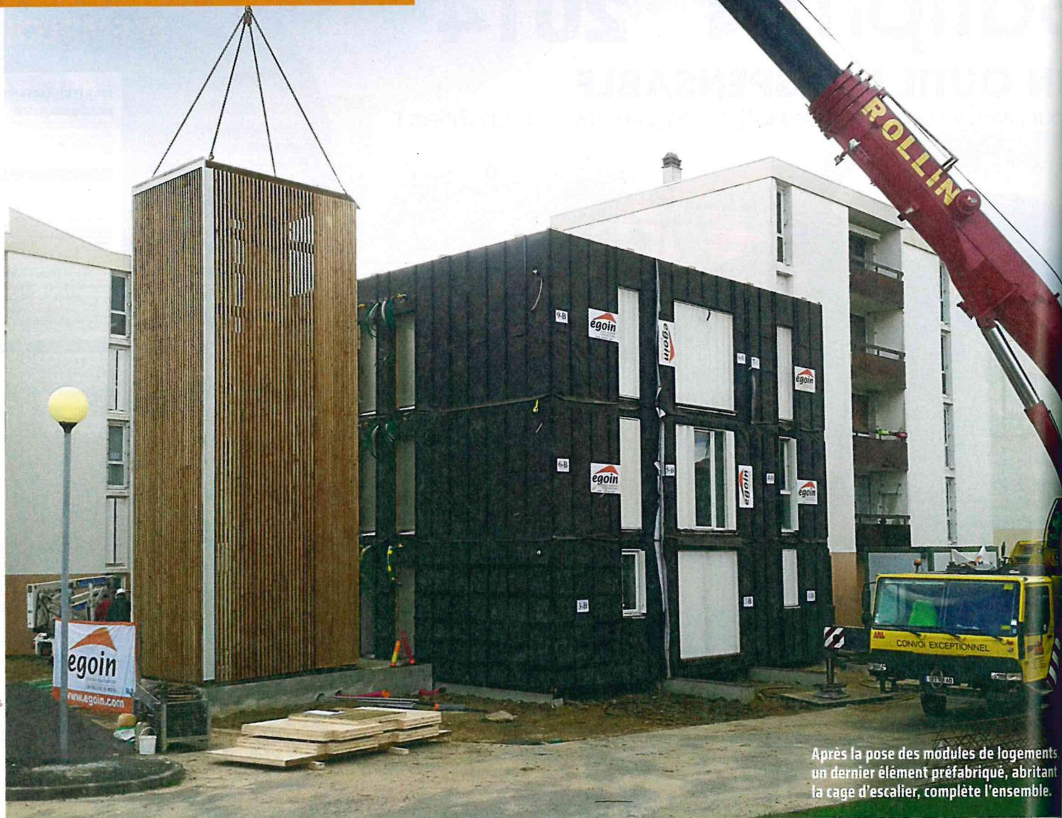
Après la pose des modules de logements un dernier élément préfabriqué, abritant la cage d'escalier, complète l'ensemble.
