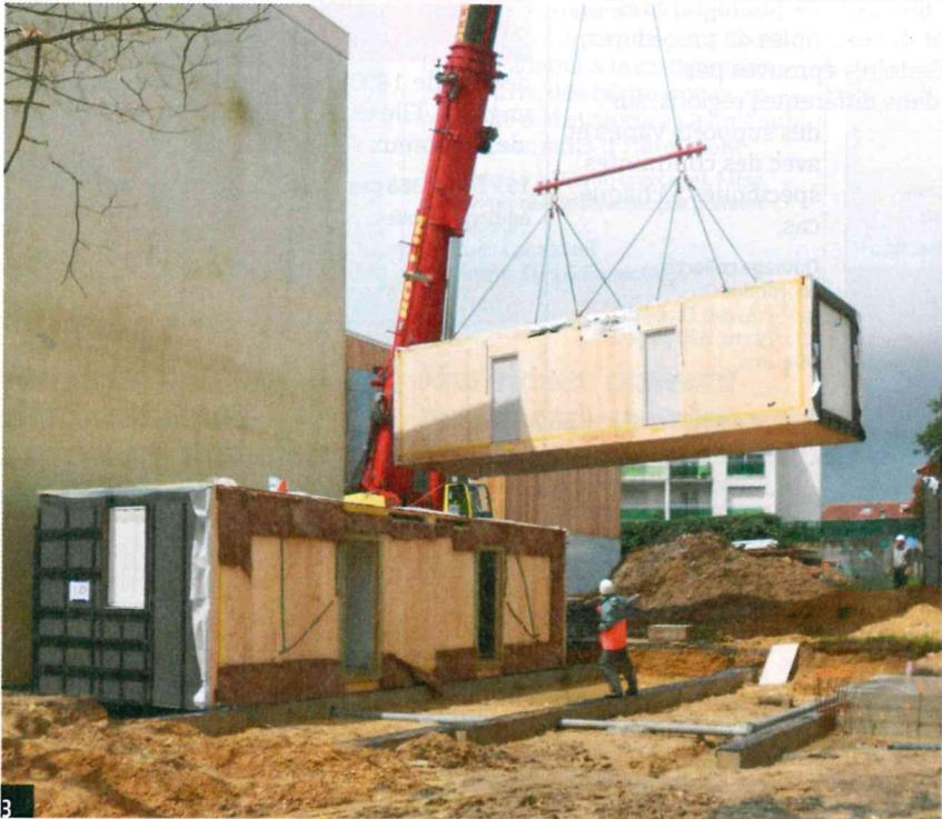
1. Trois modules de logements par étage sur trois niveaux sont posés sur un vide sanitaire. Le module de la cage d'escalier repose sur une dalle béton.
