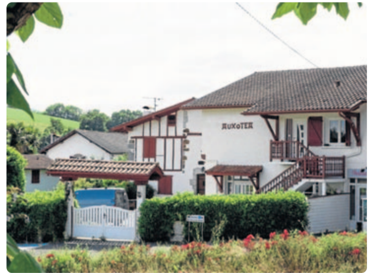
Quatre logements sont déjà disponibles à la location.
