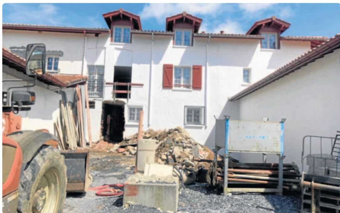
Les huit logements adaptés à la problématique du vieillissement sont en cours de construction.
