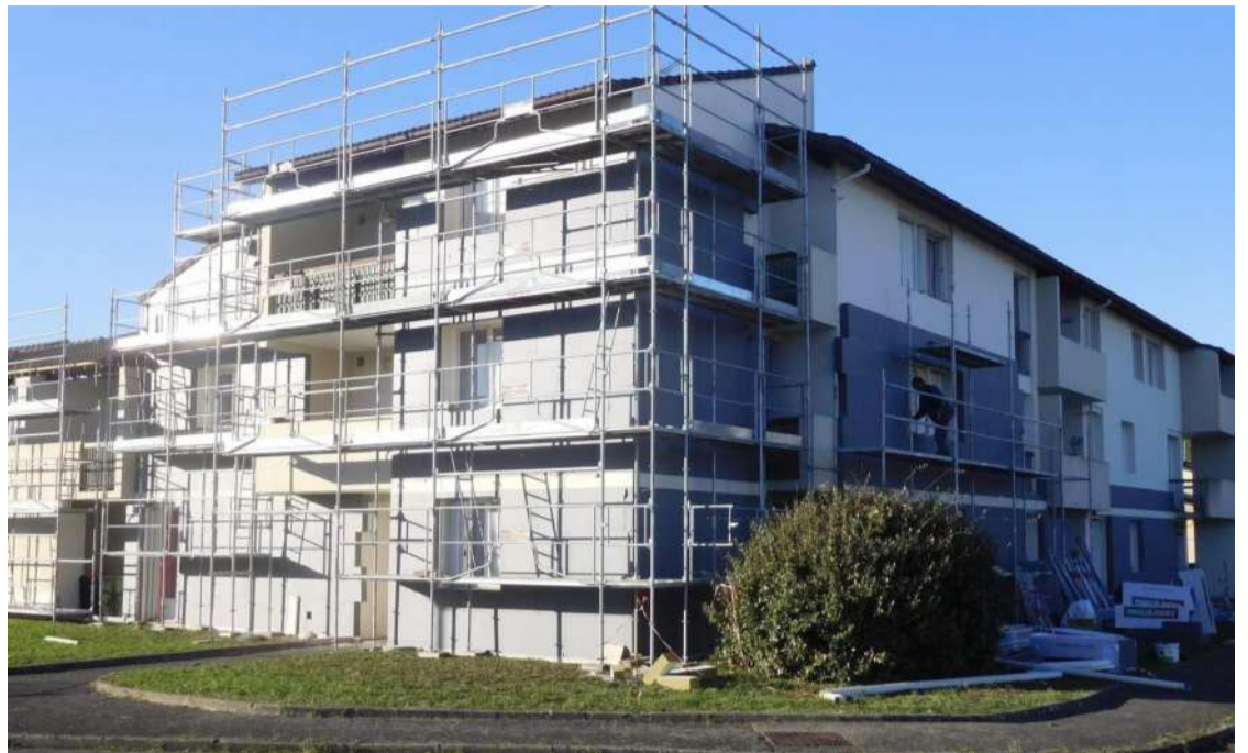
Les travaux ont été menés tout au long de l'année 2023. © DINAH SOLT
