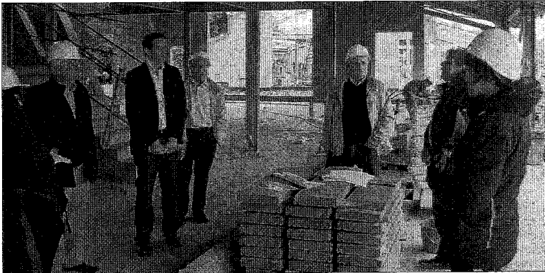
Alphonse Idart et ses adjoints visitent le chantier de l'ancienne zone de fret de la gare. PHOTO A.Y.
